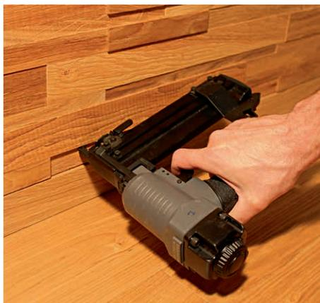
Una volta ultimata la prima fila si prosegue con il fissaggio degli altri elementi inchiodando le tavole alla sottostuttura.
