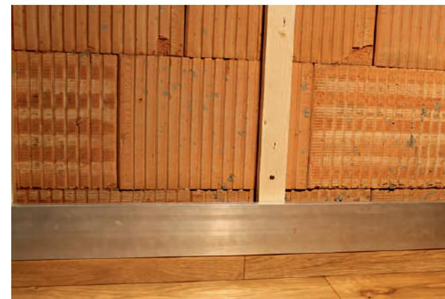
La prima fila si inizia a posare da sinistra con il maschio verso l'alto. Un bordo di chiusura Cube o un battiscopa possono essere utilizzati per compensare eventuali dislivelli.
